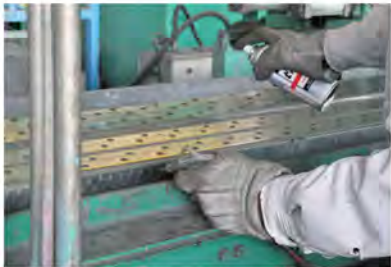
建筑用脚手架的防蚀修补
