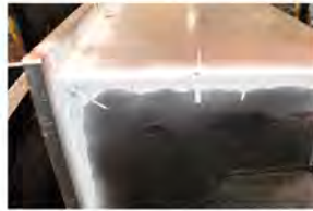
针对焊接部位的探伤检查
