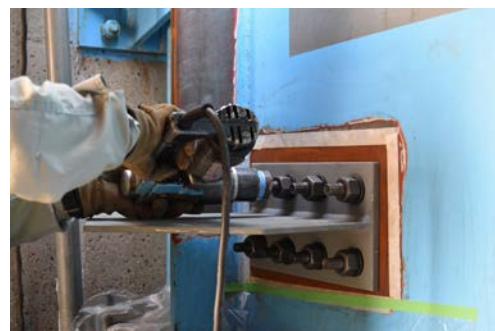
ボルト仮締め
