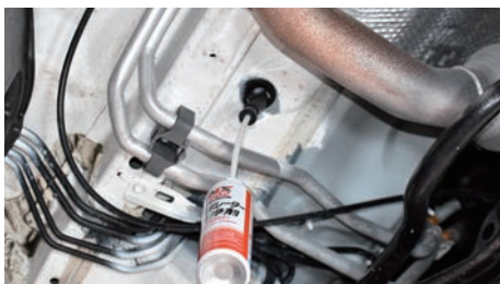
車体下部排水ドレンより注入
